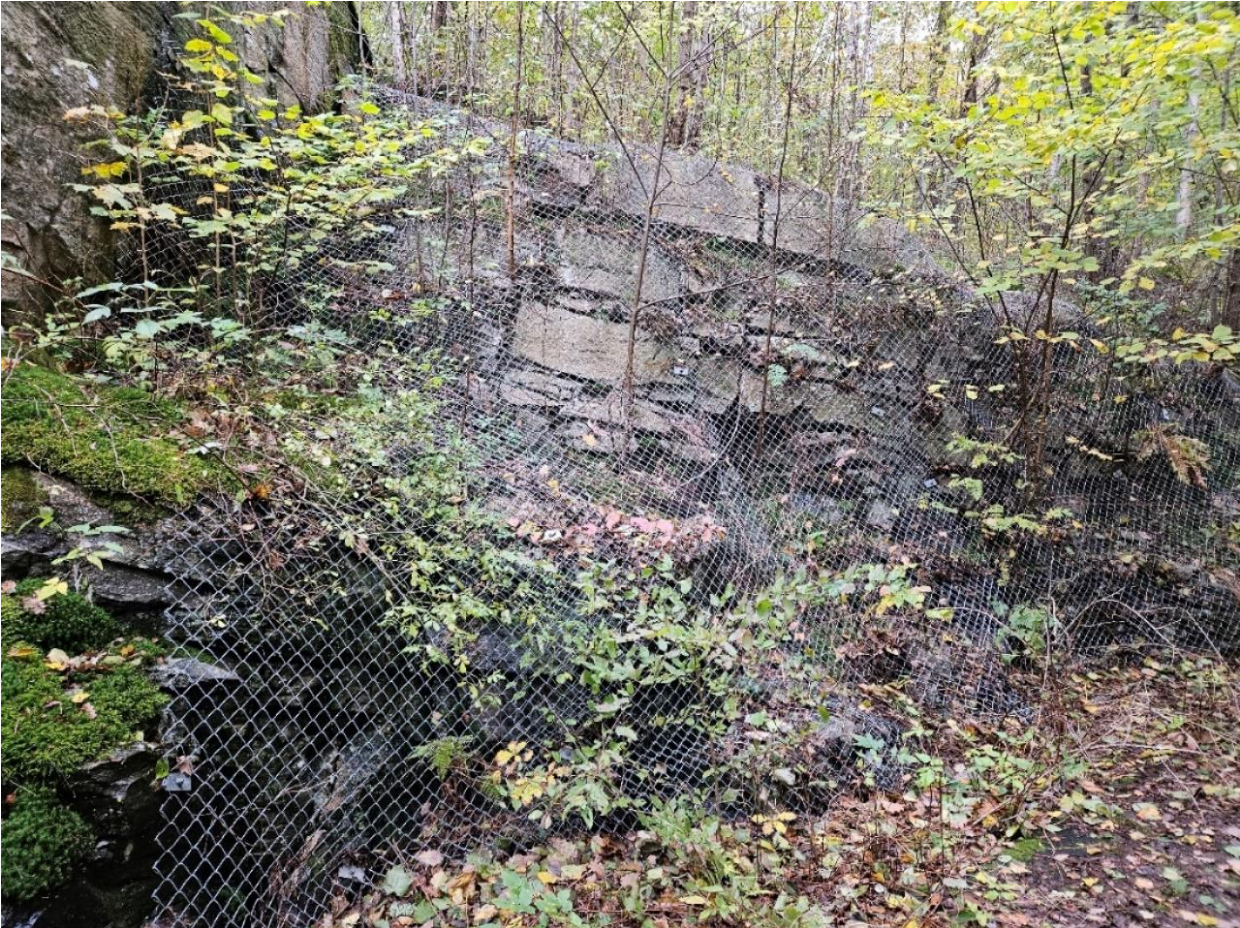
Figur 2 Fotografi av Gunnebo-bergnät i norra delen av den befintliga slänten. Vegetation bakom nätet kan komma att påverka bergskvilltet och nätet funktion i framtiden. Se skada 1 i figur 8.
